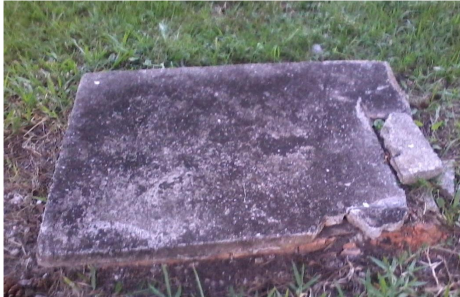
FIGURA 12 - Caixa separadora. Fonte: Autor, 2014.
