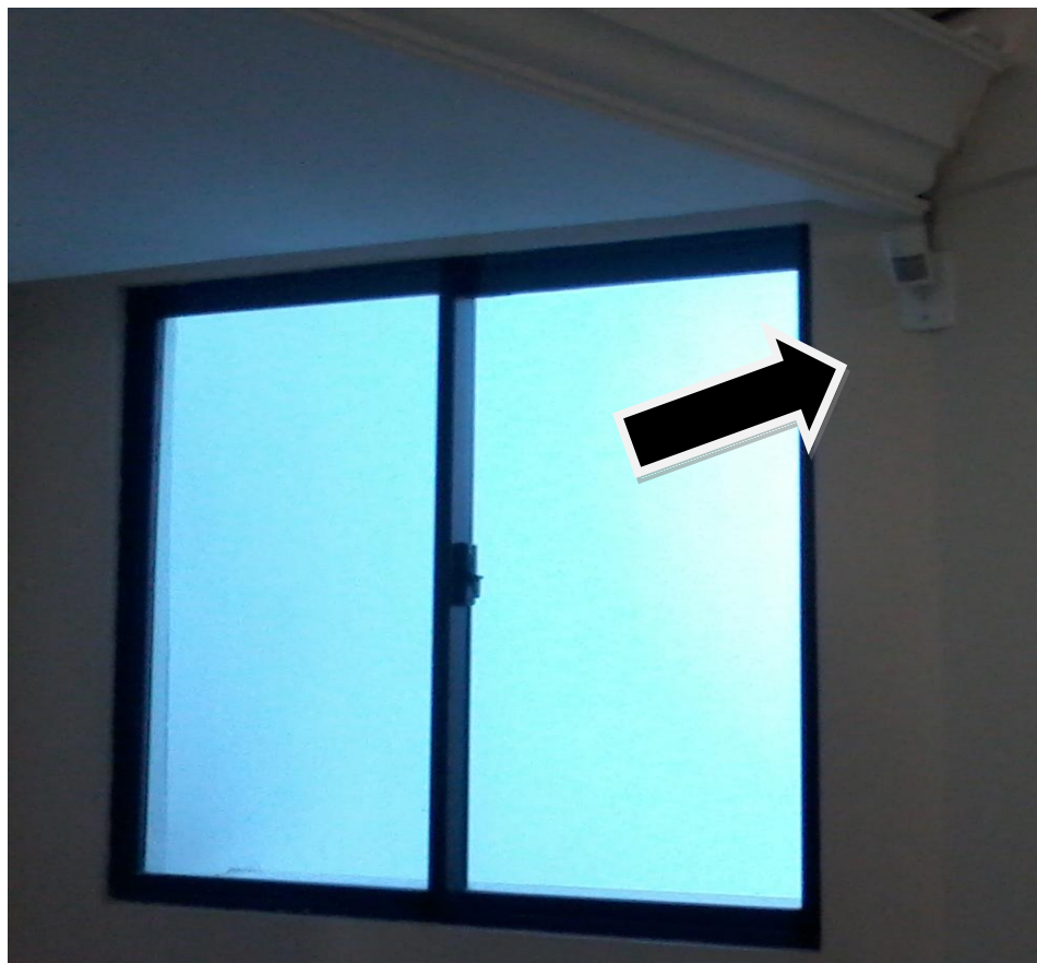
FIGURA 10 - Sensores de movimentos, presentes em todos os corredores do Hotel A.
