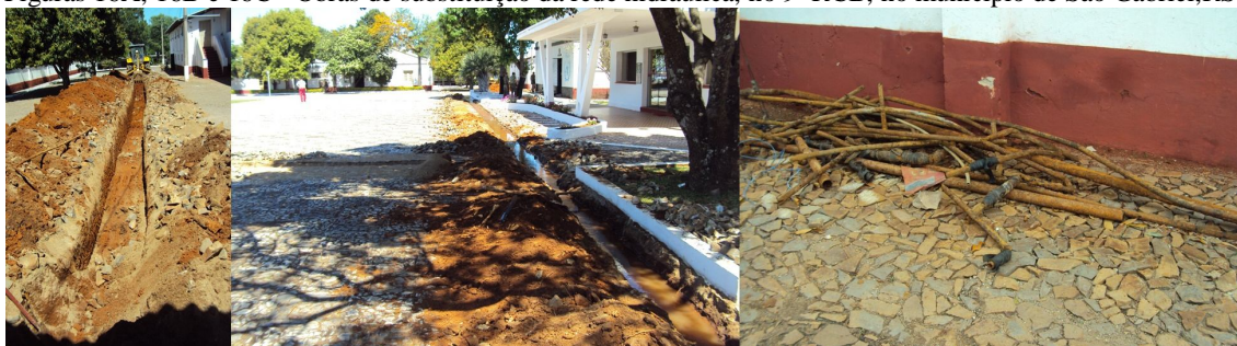
Figuras 16A, 16B e 16C - Obras de substituição da rede hidráulica, no 9º RCB, no município de São Gabriel,RS.
