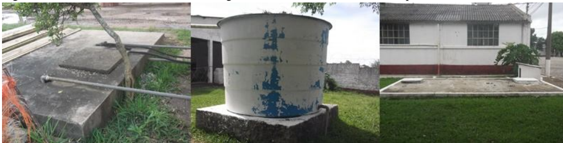
Figuras 15A, 15B e 15C - Reservatórios de água da chuva do 9º RCB, no município de São Gabriel,RS.
