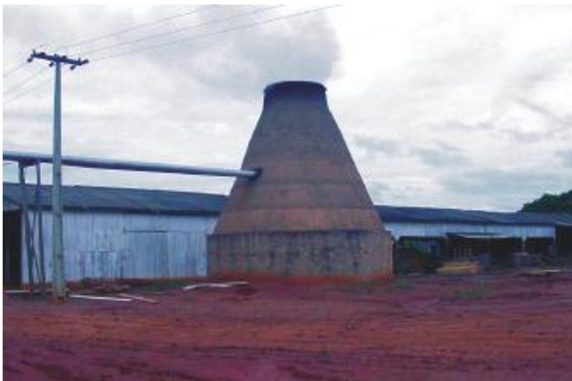
Figura 9 – Forno de incineração de resíduos dos tipos serragem e maravalhas. Fonte: ARAUJO, 2003.
