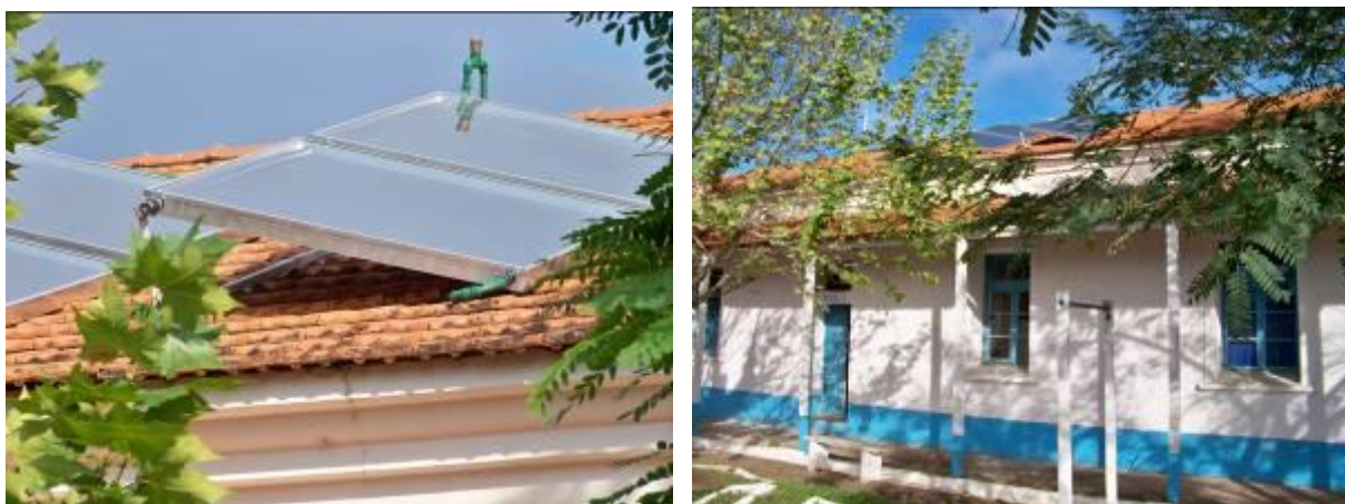
Figura 2 e 3 - Aquecimento solar da água em alojamentos na 13ª Companhia de Comunicações Mecanizada, São Gabriel, RS.
