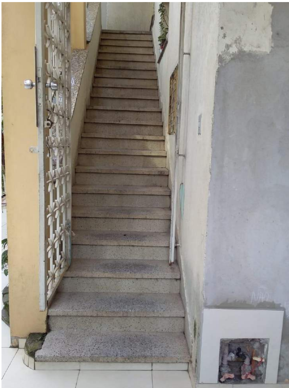
Figura 43: Vista escadaria de acesso ao segundo pavimento - unidade residencial existente
