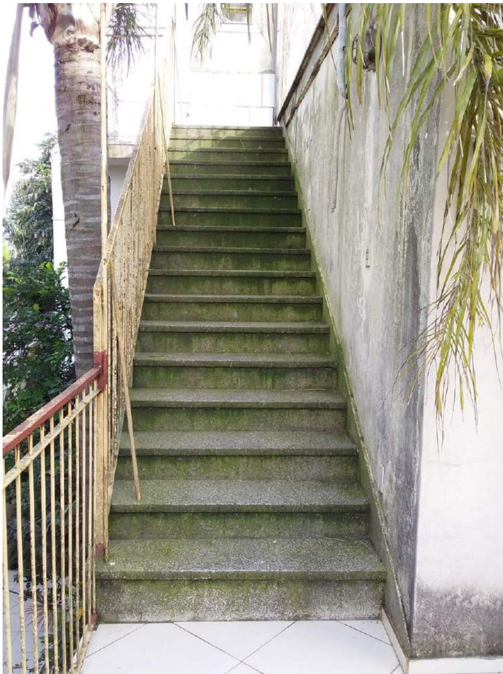
Figura 45: Vista acesso escadaria para o terceiro pavimento
