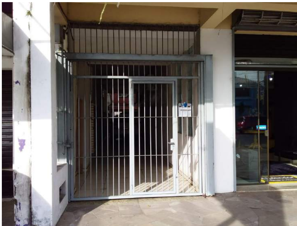
Figura 42: Vista entrada ambiente residencial
