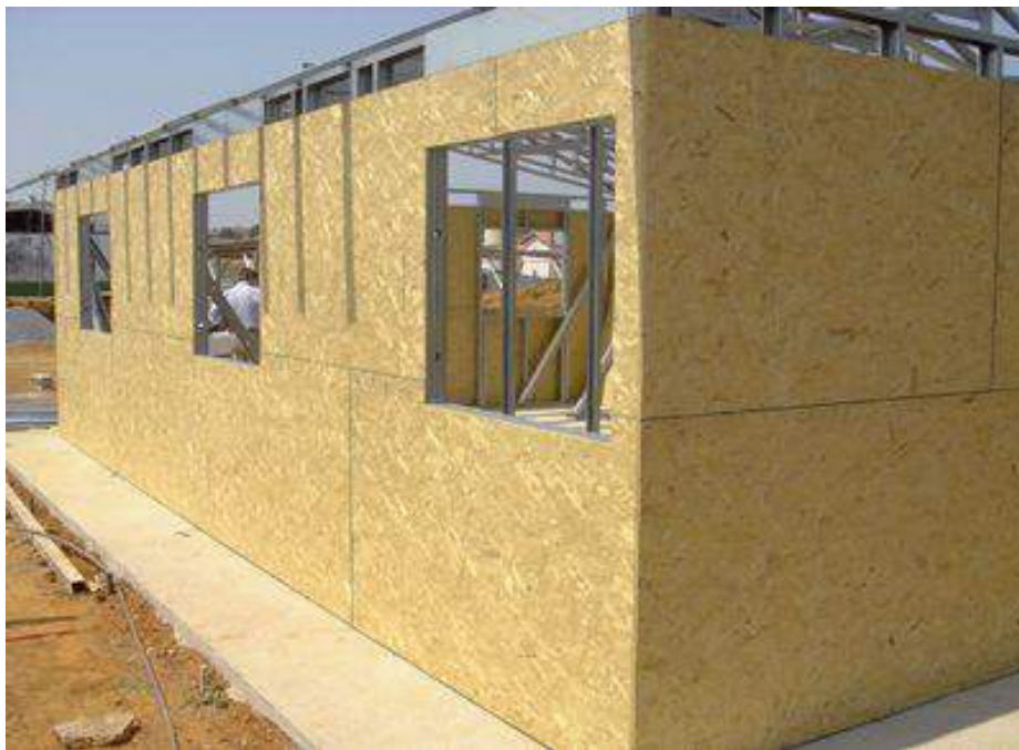
Figura 11 – Placas OSB aplicadas em estrutura do tipo LSF
