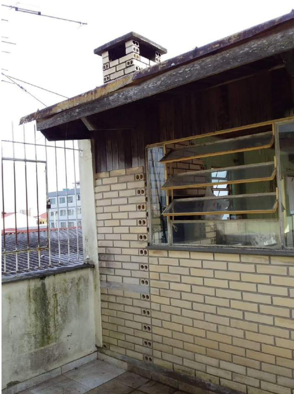
Figura 46: Vista do acesso do terceiro pavimento ao salão de festa
