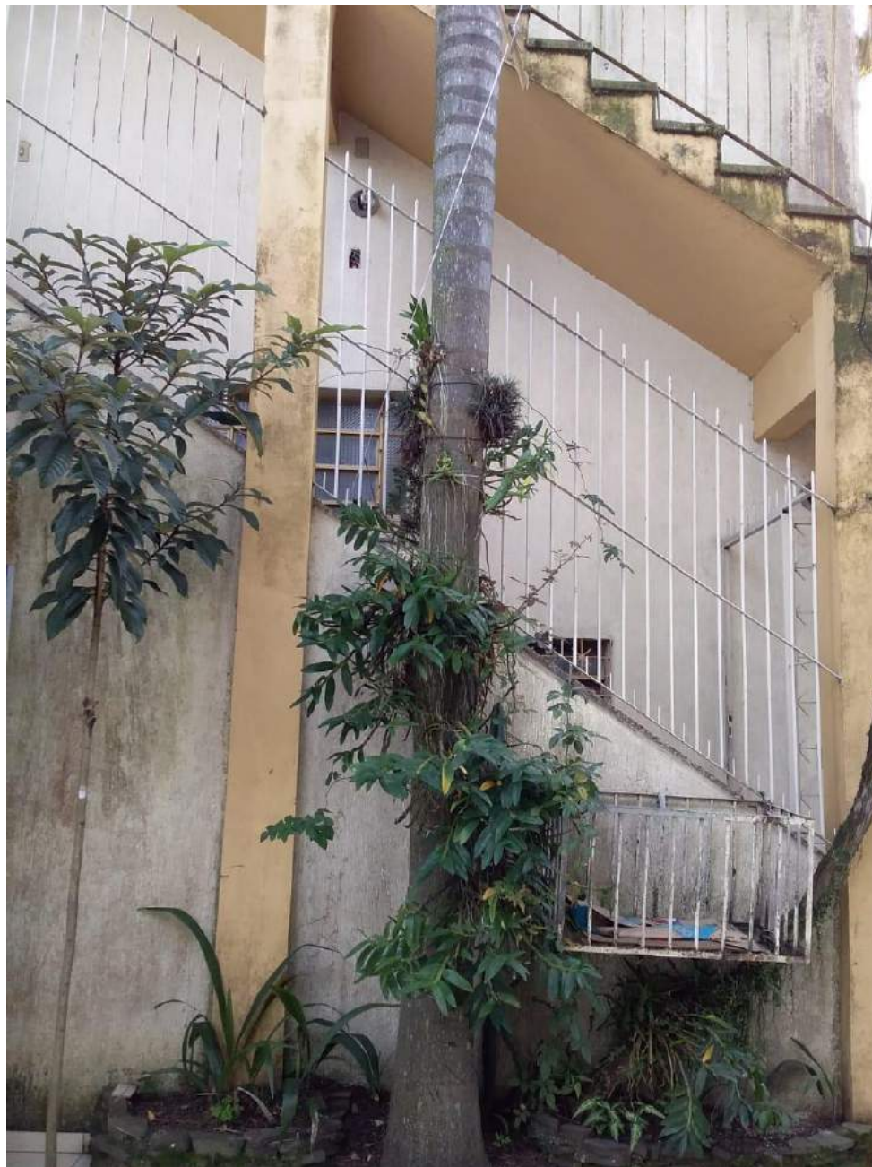
Figura 44: Vista escadarias que garantem acesso aos segundo e terceiro pavimentos da unidade residencial da edificação existente
