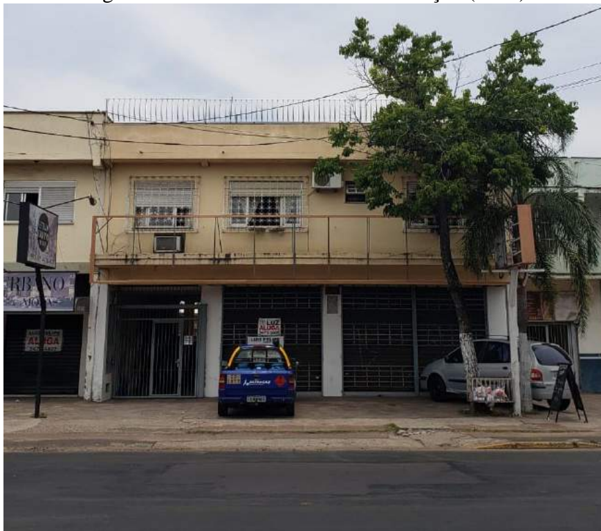
Figura 39: Fachada existente da edificação (2019)
