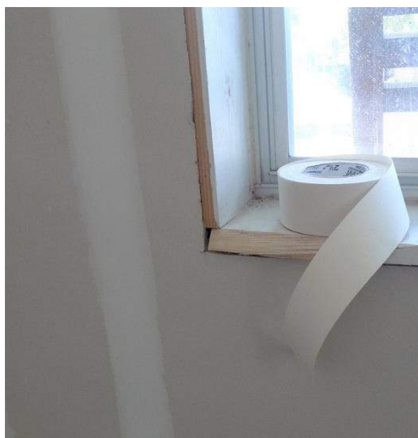
Figura 20 – Regularização de superfície com massa para rejunte e fita de papel microperfurado
