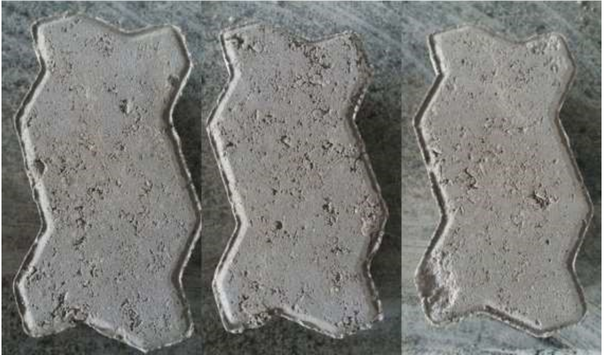
Figura 47 - Aspecto Visual dos Pavers Pref
