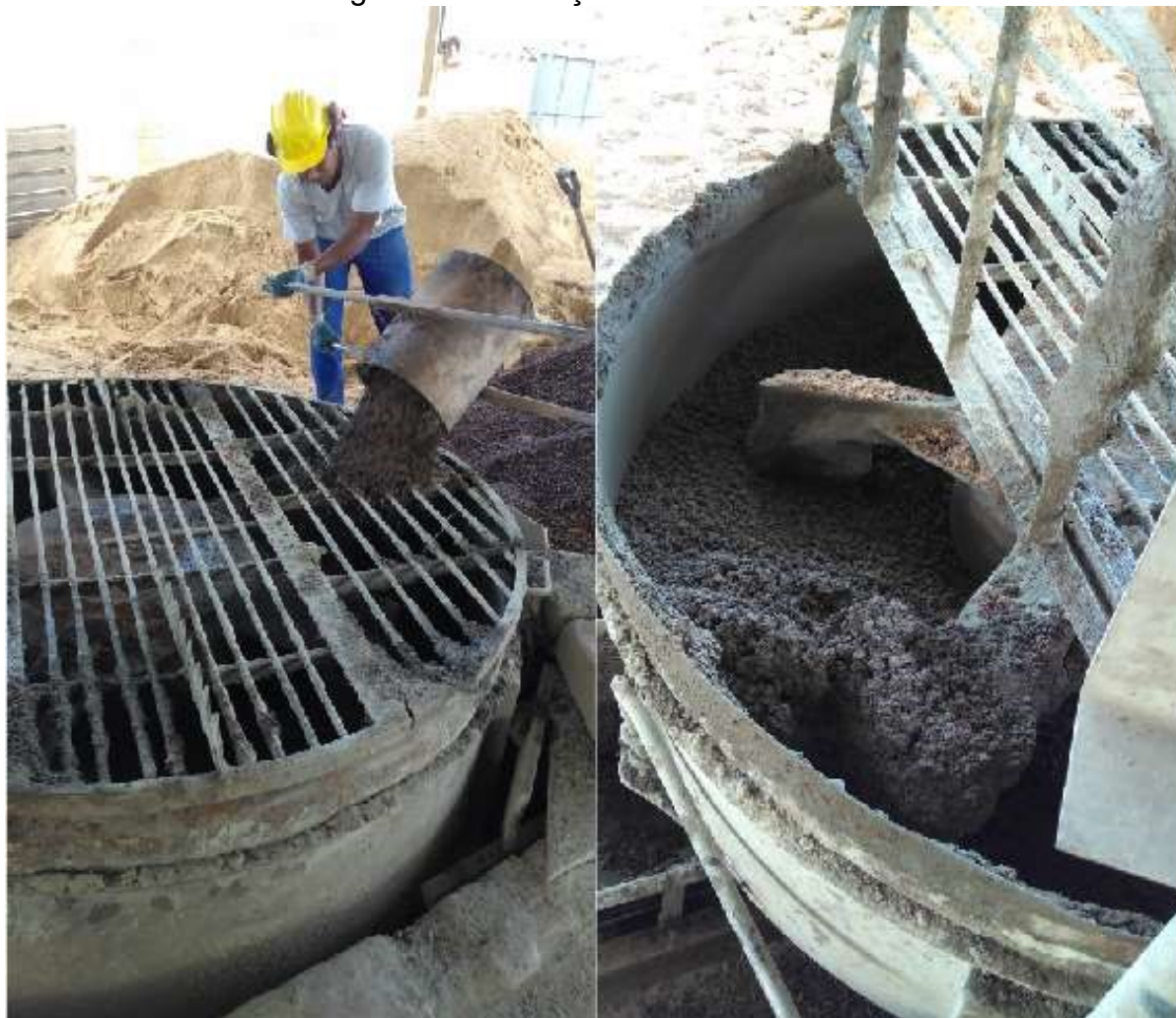
Figura 11 - Produção de concreto seco
