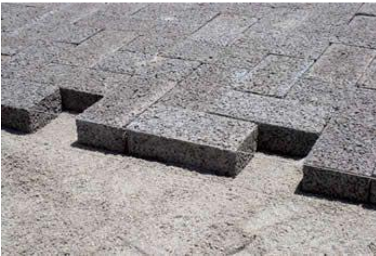
Figura 4 – Pavimento de pavers de concreto permeável.
