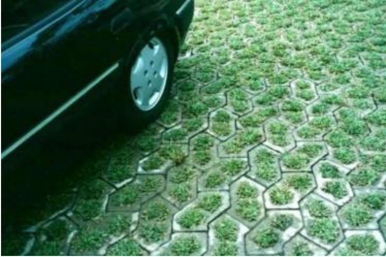
Figura 5 – Pavimento com blocos de concreto vazado
