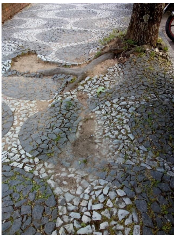
Figura 41 – Afloramento da raiz de um indivíduo da espécie Ingá vera ( Ingá ) causando sérios danos ao calçamento da Praça Largo Farroupilha, Caçapava do Sul – RS, 2018.
