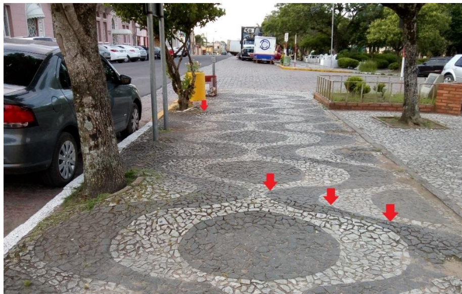
Figura 41 – Afloramento da raiz de um indivíduo da espécie Ingá vera ( Ingá ) causando sérios danos ao calçamento da Praça Largo Farroupilha, Caçapava do Sul – RS, 2018.
