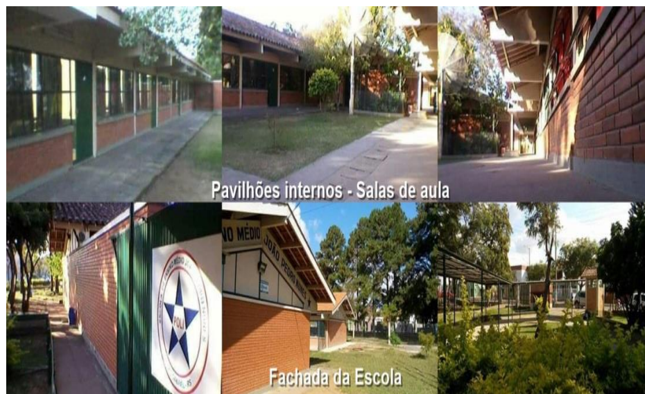
Figura 4 – Fotografia dos pavilhões internos e da fachada da escola
