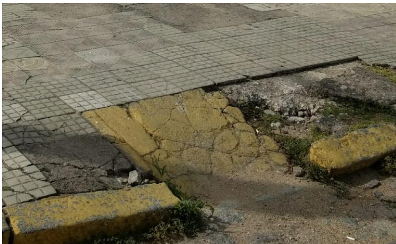
Figura 18 - Rampa de Acesso na Praça Alcides Marques.
