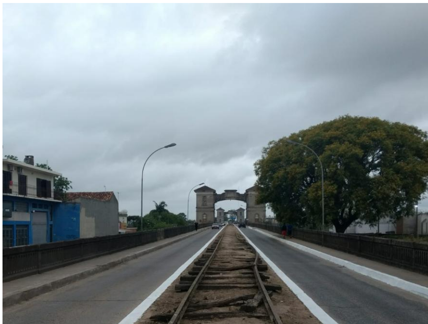
Figura 13 - Vista de cima da Ponte.
