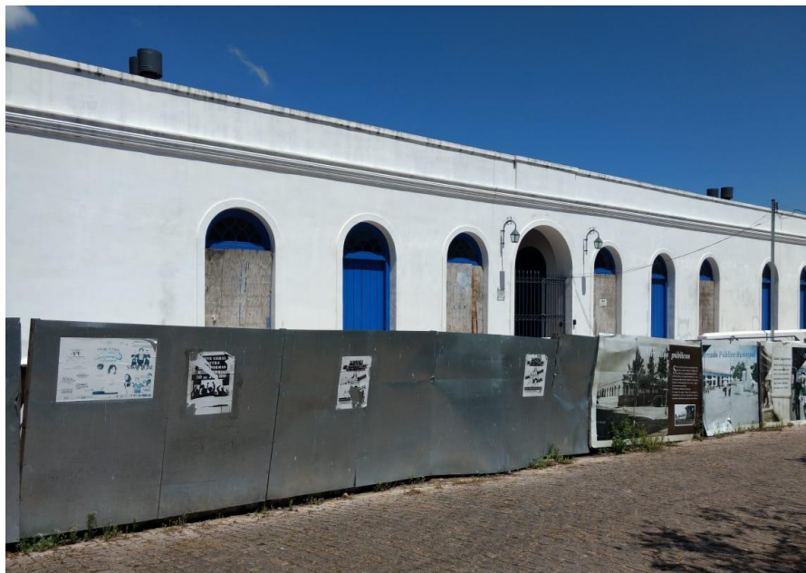
Figura 11 - Fachada Mercado Público Municipal de Jaguarão-RS.
