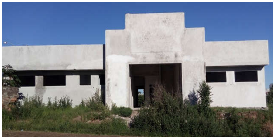
Figura 17 – Fachada da nova unidade de saúde Rio Uruguai em obras.
