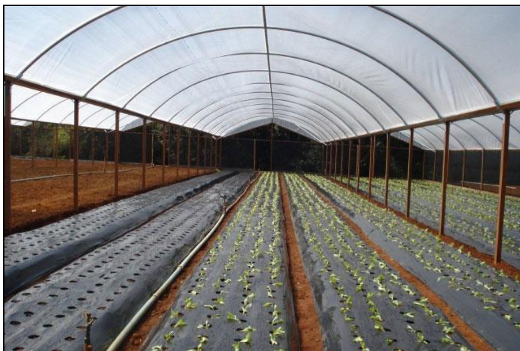
Figura 32 – Estufa de testes em fase de construção.
