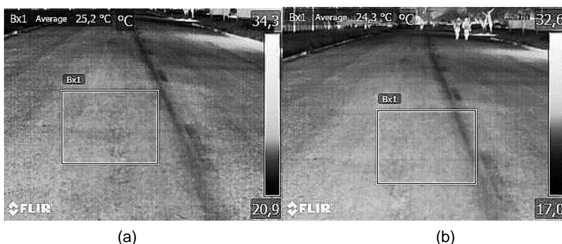
Figura 38 - Imagens termográficas no sentido longitudinal da pista de rolagem
