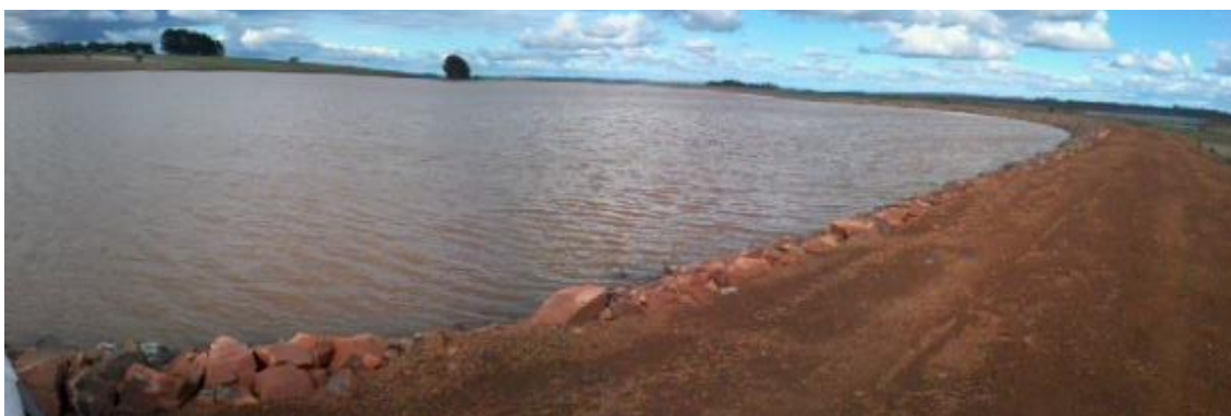
Figura 21 - Vista panorâmica da barragem correspondente aos solos S1 e S2
