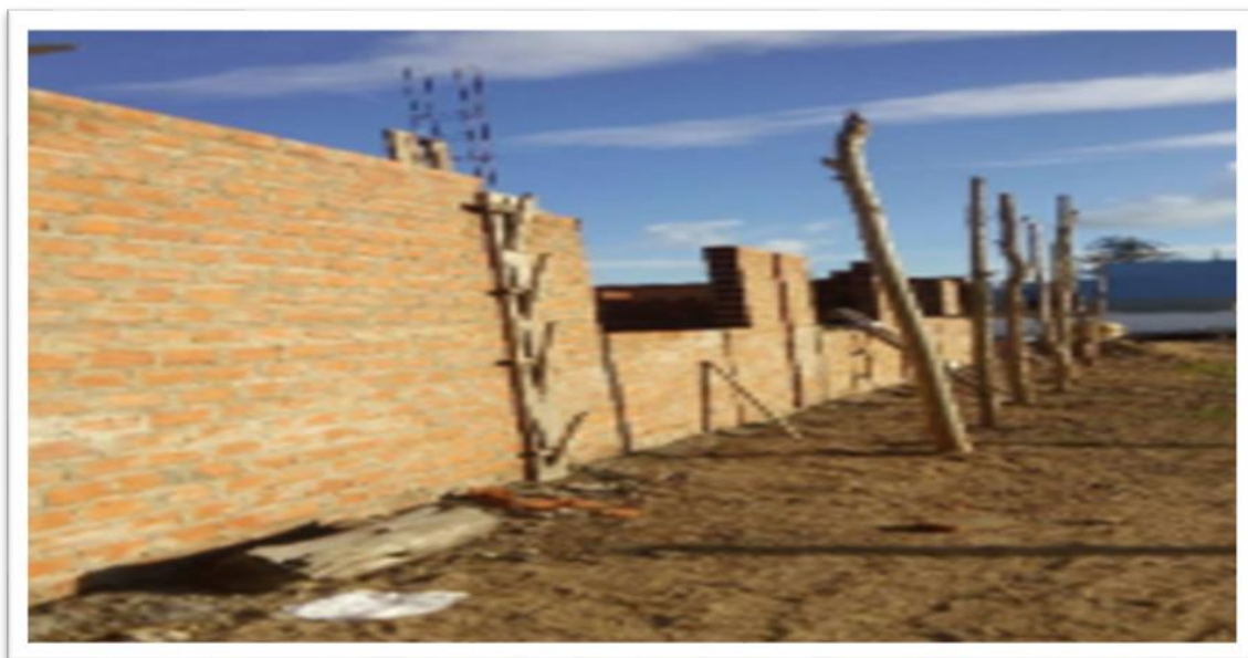
Figura 5: 2018 Construção das novas salas na frente da escola
