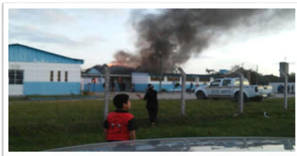
Figura 2 - 2016- Incêndio num dos prédios da Escola
