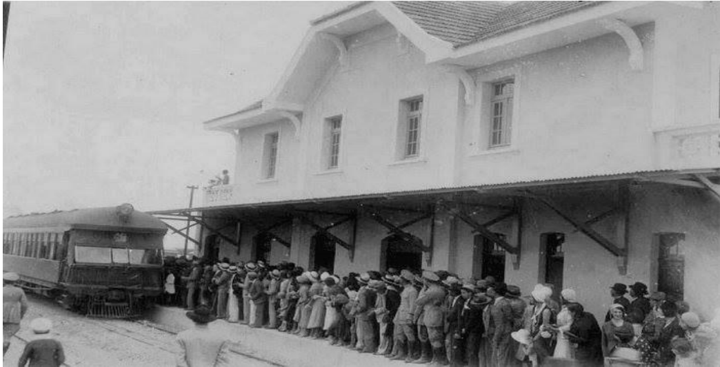
Figura 4: Prédio da Estação Ferroviária nos anos de 1932
