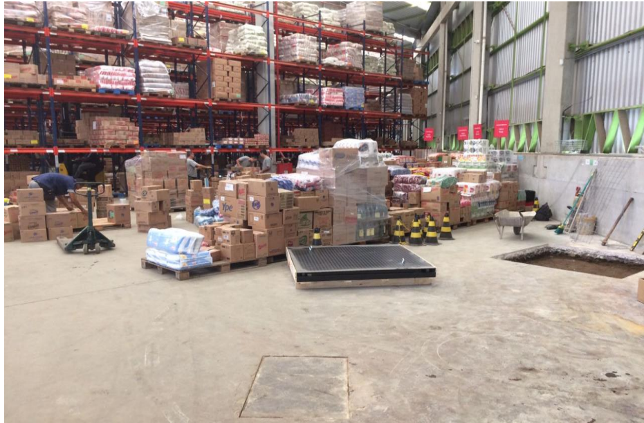
Figura 43 – Início da instalação da balança com o Buffer em fundo
