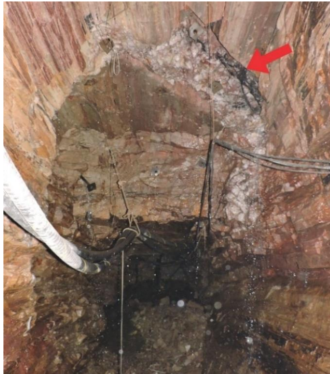
Figura 5 - Veios de quartzo com óxido de manganês (seta vermelha) no entorno das galerias subterrâneas.
