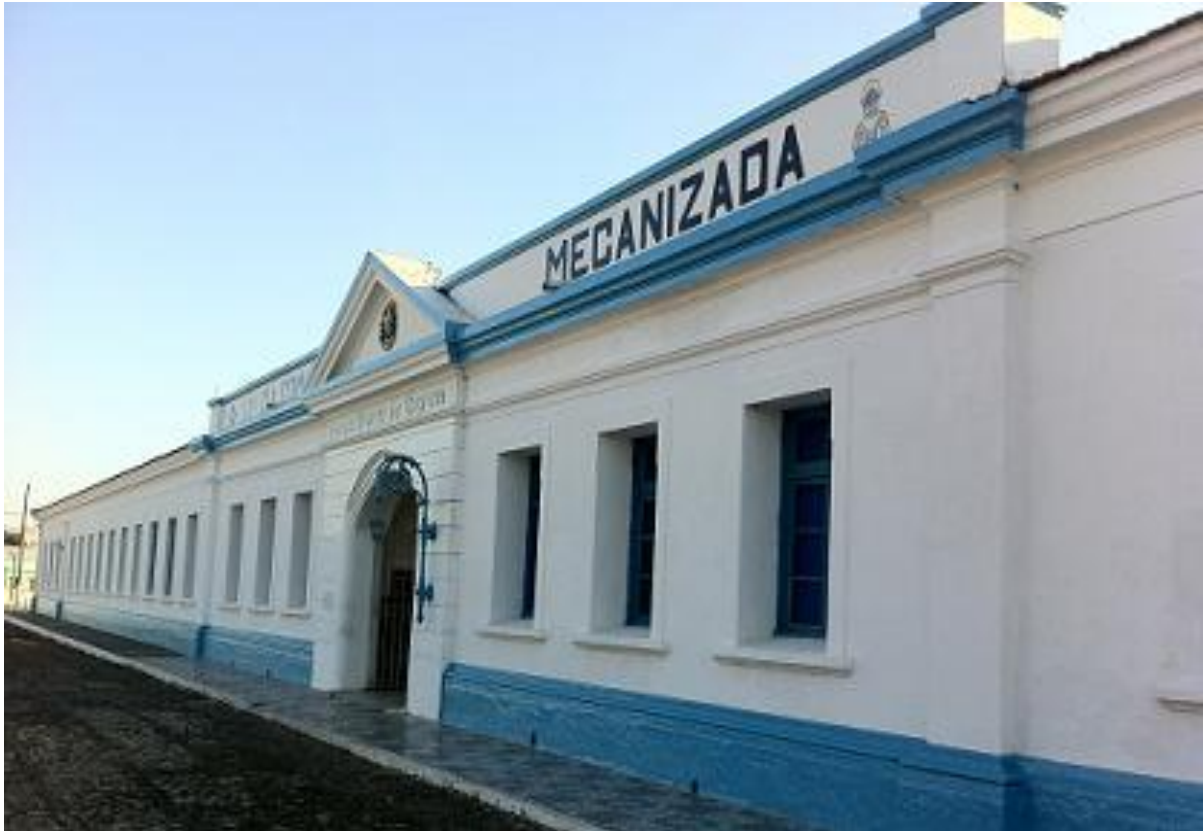
Figura 1 – Fachada da 13ª Cia Com Mec
