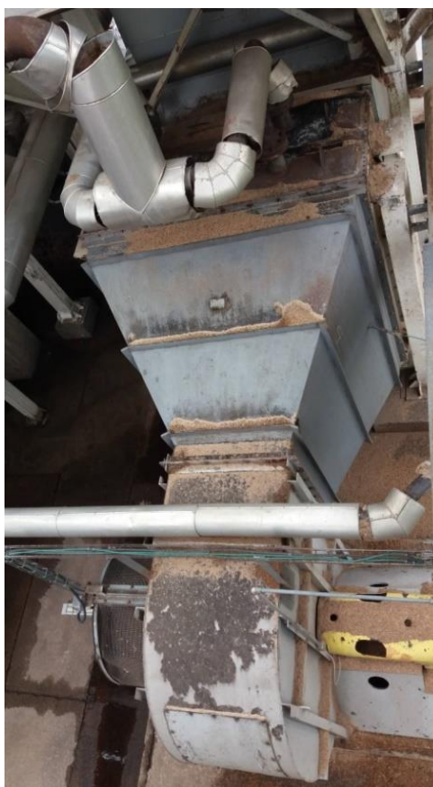
Figura 41 - Pré aquecedor de ar secundário
