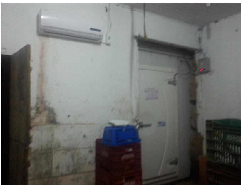
Figura 14 – Entrada da câmara fria
