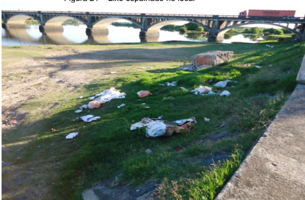
Figura 21 – Lixo espalhado no local
