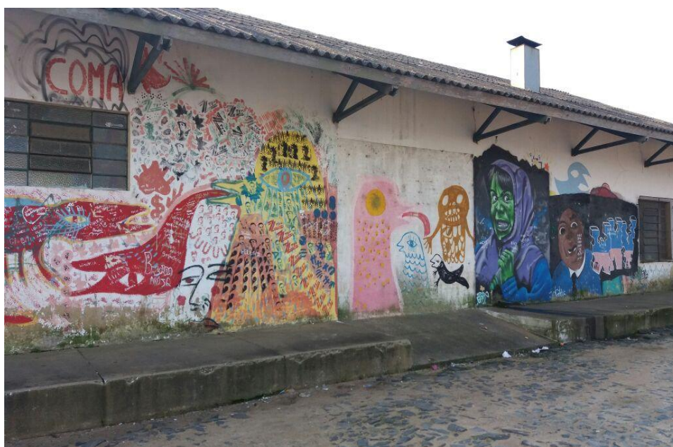
Figura 29 – Parede do galpão
