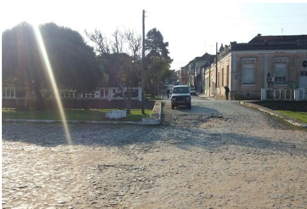
Figura 27 – Sinalização precária em todas as vias de acesso
