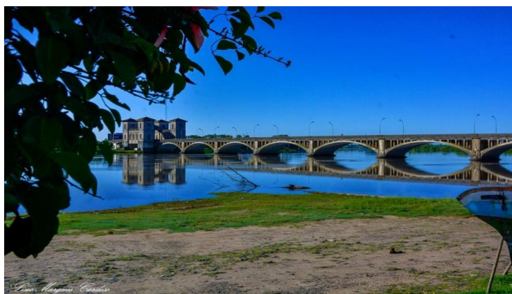
Figura 5 – Ponte Internacional Mauá
