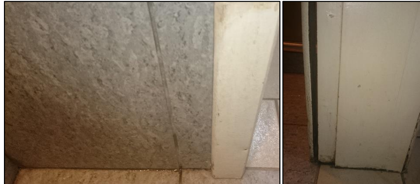
Figura 41 - Empenamento em peça de Madeira
