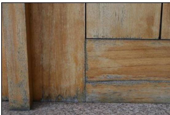
Figura 40 - Mudança de Tonalidade em Peça de Madeira
