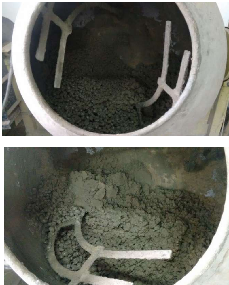
Figura 20 – Mistura dos constituintes do concreto
