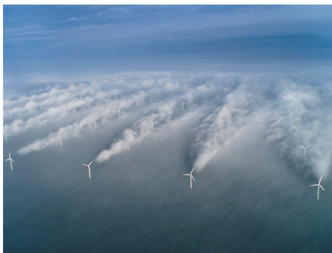
Figura 7 – Representação da esteira formada na fazenda eólica de Horns Rev.
