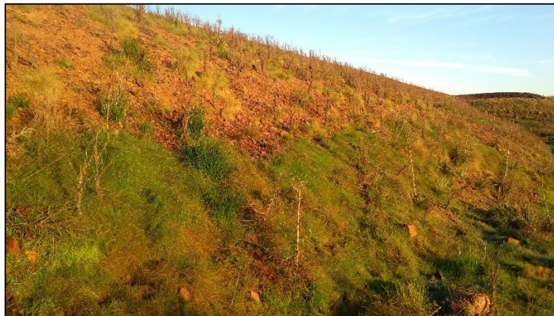
Figura 79 – Fuga d'água e áreas úmidas no talude a jusante da propriedade B-07
