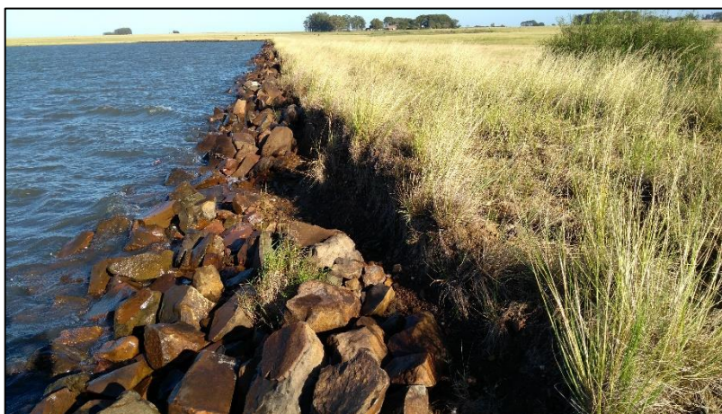
Figura 30 – Rip-rap do talude a montante da propriedade B-02
