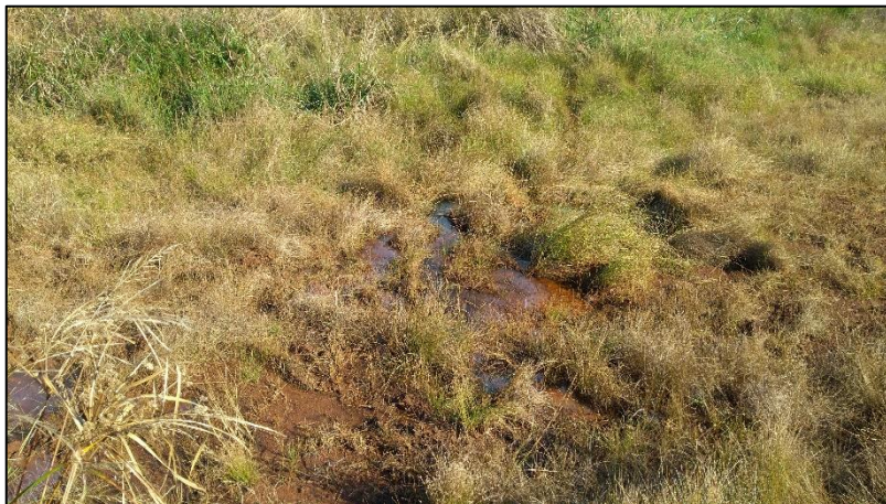
Figura 88 – Fuga d'água na região a jusante da propriedade B-08
