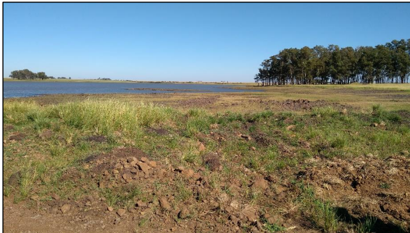
Figura 97 – Aterro no vertedouro da propriedade B-01
