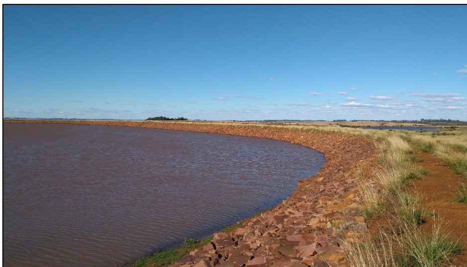
Figura 13 – Foto panorâmica a montante do barramento B-08
