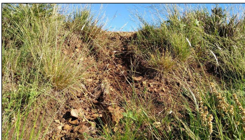
Figura 60 – Falha proteção vegetal no talude a jusante da propriedade B-01
