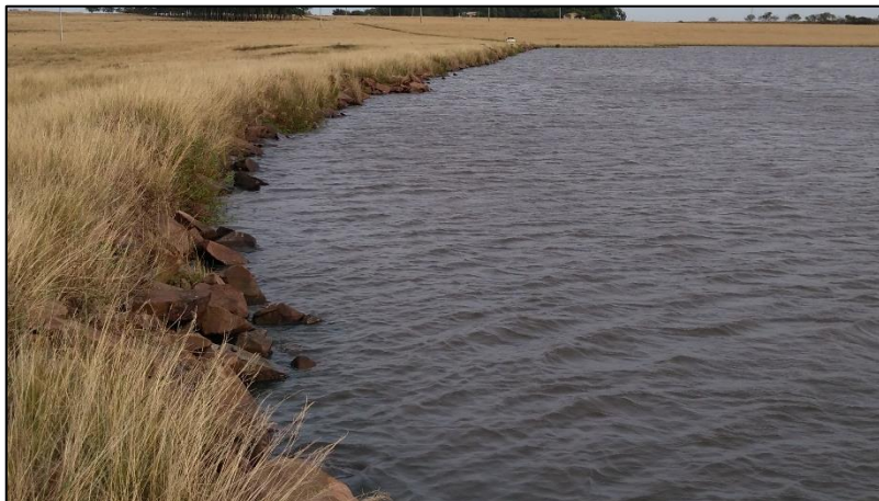
Figura 49 – Ameaça de transbordamento da propriedade B-03
