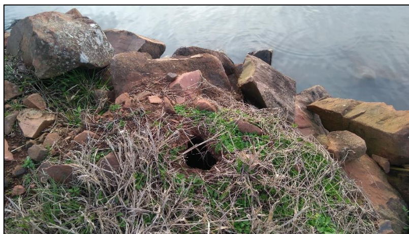
Figura 44 – Toca de animal no coroamento da propriedade B-04
