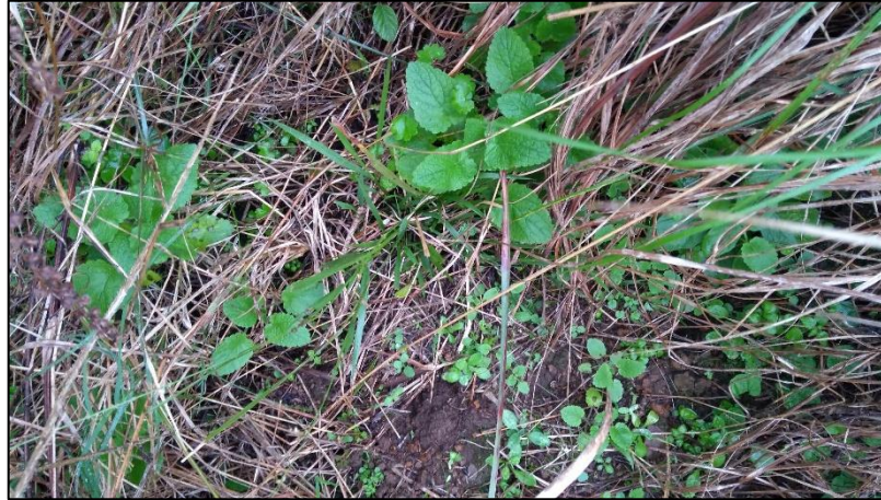
Figura 78 – Área úmida no talude a jusante da propriedade B-05
