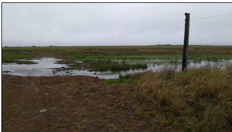
Figura 101 – Aterro e vegetação no vertedouro da propriedade B-05
