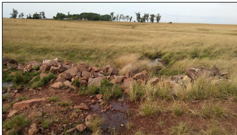
Figura 91 – Obstruções ou entulho na região a jusante da propriedade B-03
