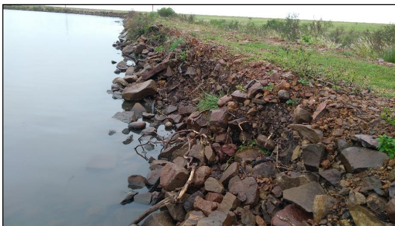
Figura 32 – Rip-rap do talude a montante da propriedade B-05
