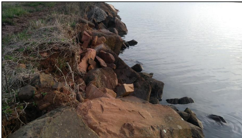
Figura 31 – Rip-rap do talude a montante da propriedade B-04
