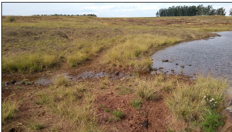
Figura 102 – Aterro e vegetação no vertedouro da propriedade B-06
