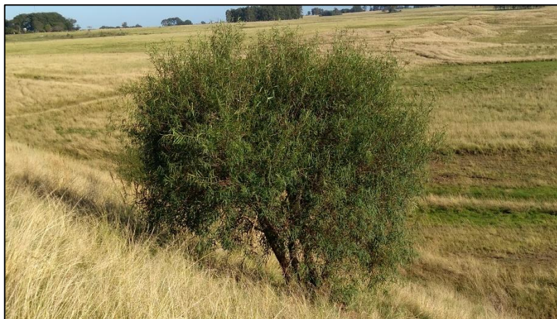
Figura 68 – Árvores e arbustos no talude a jusante da propriedade B-02
