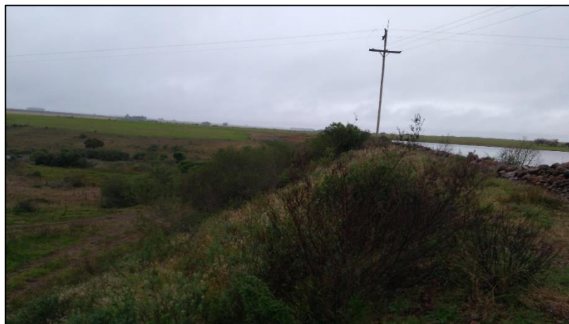
Figura 90 – Árvores/Arbustos na região a jusante da propriedade B-05
