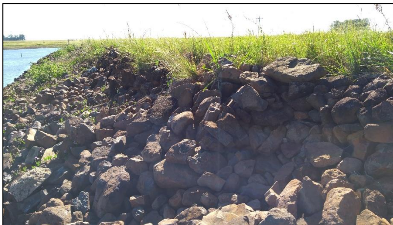
Figura 29 – Rip-rap do talude a montante da propriedade B-01
