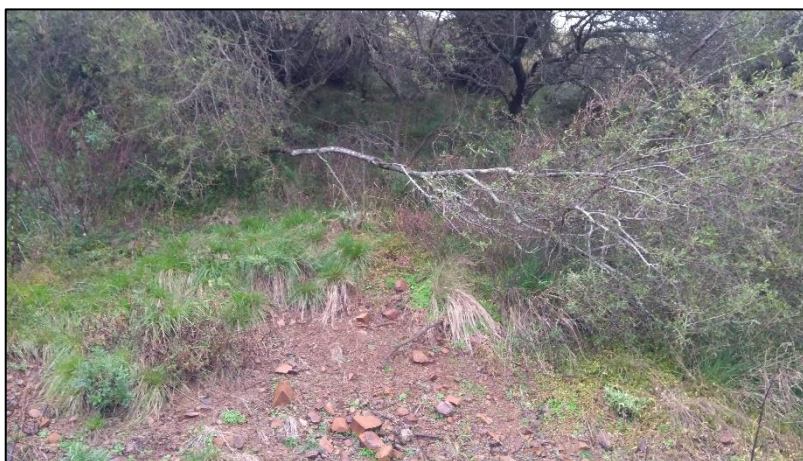
Figura 74 – Sinais de movimento no talude a jusante da propriedade B-05
