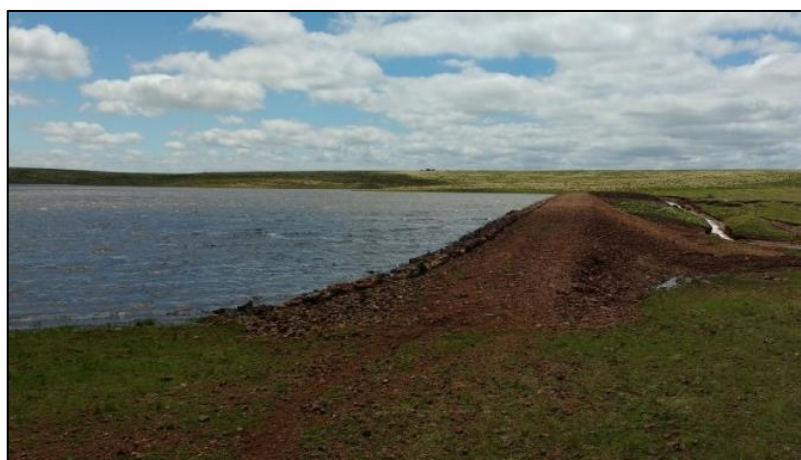
Figura 51 – Ameaça de transbordamento da propriedade B-07
