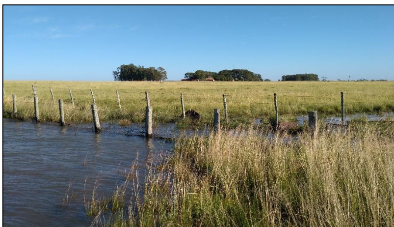
Figura 98 – Cerca no vertedouro da propriedade B-02
