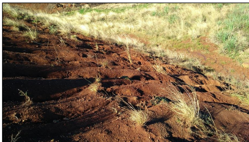
Figura 56 – Erosão no talude a jusante da propriedade B-08
