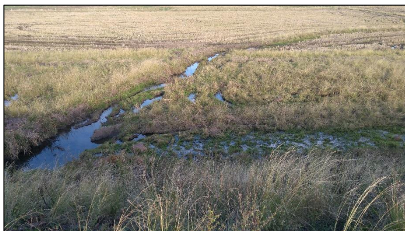
Figura 84 – Fuga d'água na região a jusante da propriedade B-04
