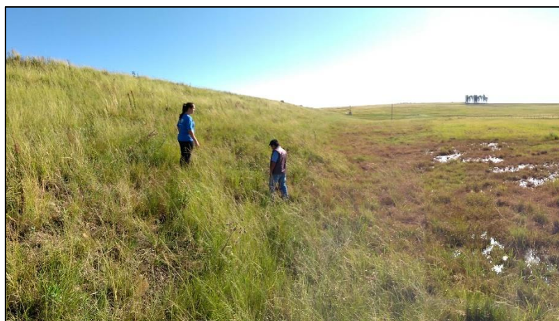
Figura 81 – Fuga d'água na região a jusante da propriedade B-01
