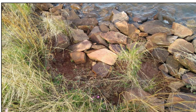
Figura 33 – Rip-rap do talude a montante da propriedade B-06
