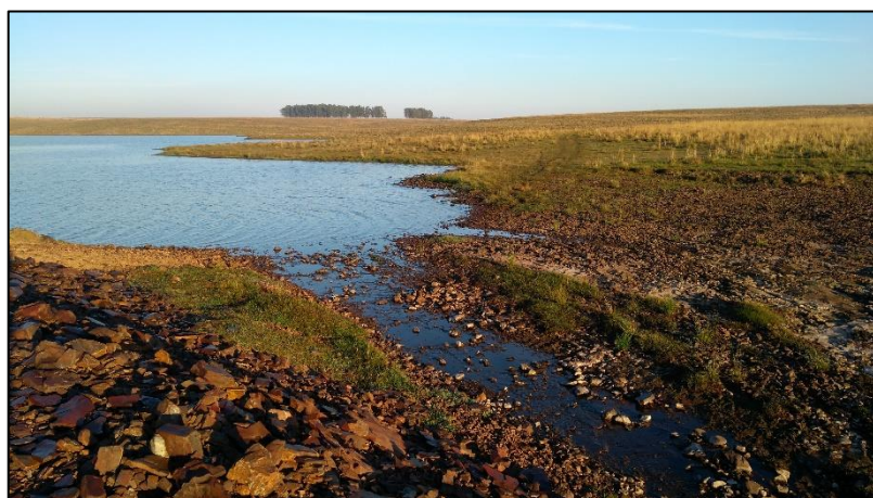
Figura 103 – Aterro e vegetação no vertedouro da propriedade B-07
