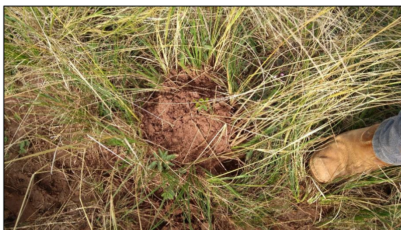
Figura 46 – Formigueiro no coroamento da propriedade B-06
