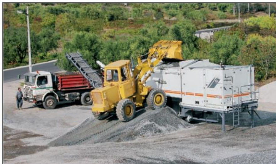
Figura 19 – Usina de reciclagem a frio
