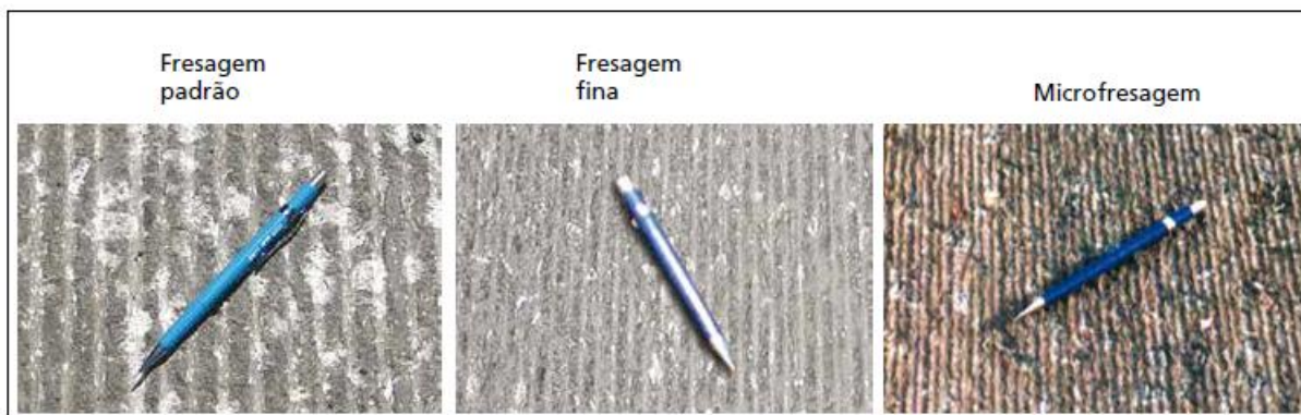
Figura 10 – Rugosidade após a fresagem na pista
