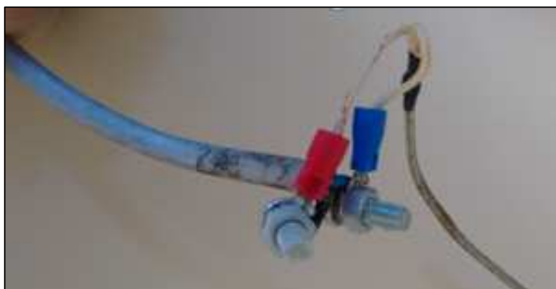
Figura 30 – Ligação com fio PlastiChumbo.
