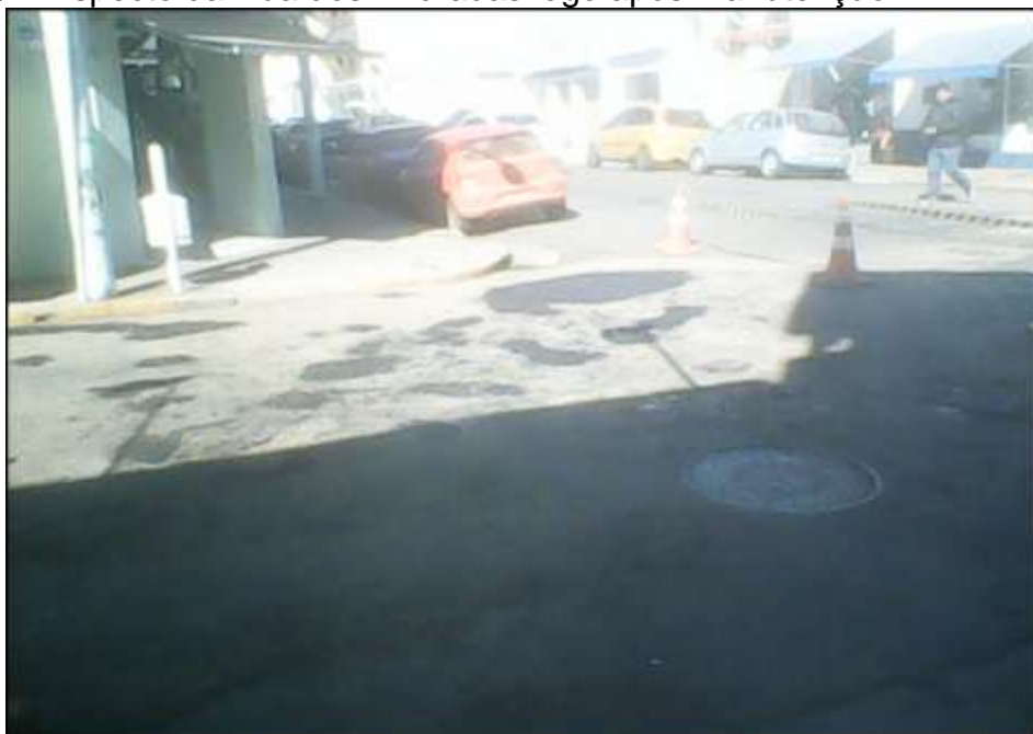
Figura 20 – Aspecto da Rua dos Andradas logo após manutenção
