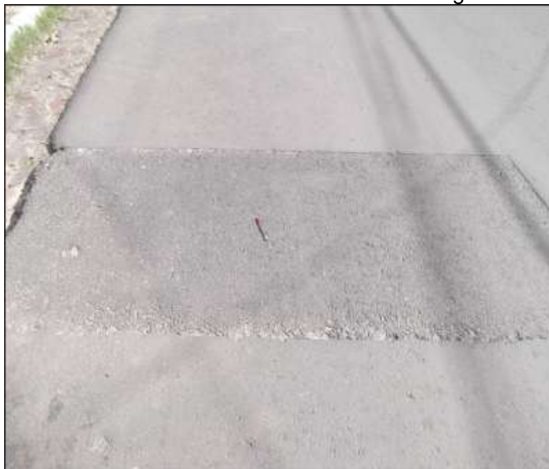
Figura 9 – Remendo visto na Rua Barão do Amazonas – Alegrete - RS
