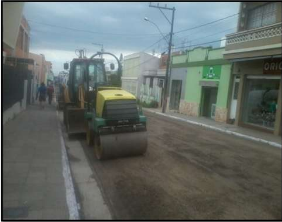
Figura 25 – Aspecto da Rua dos Andradas pós fresagem
