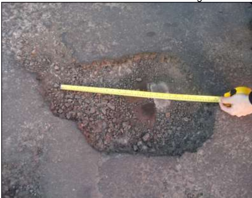
Figura 8 – Painela encontrada na Rua dos Andradas – Alegrete-RS
