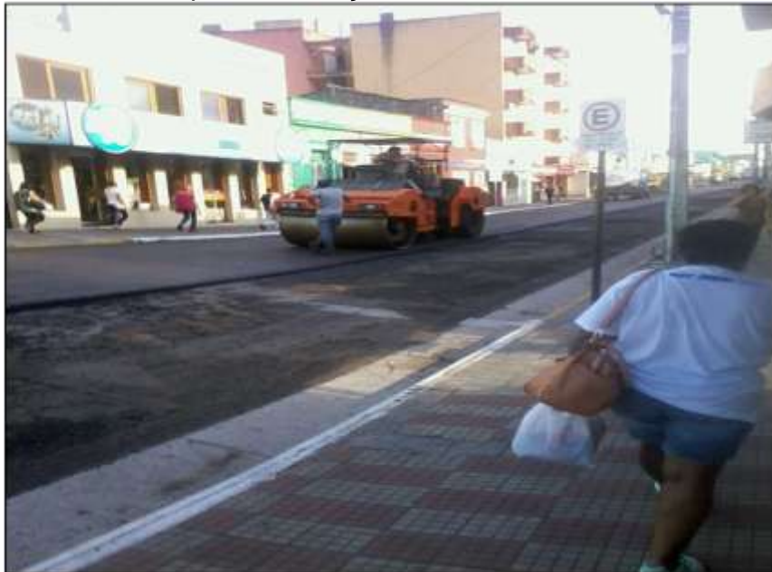
Figura 26 – RECAP 2 em plena execução na Rua dos Andradas
