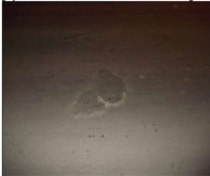
Figura 5 – Corrugação encontrada na Rua Bento Manoel – Alegrete-RS
