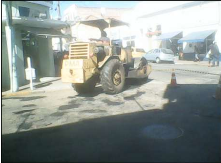
Figura 19 – Operação tapa-buraco realizada na Rua dos Andradas
