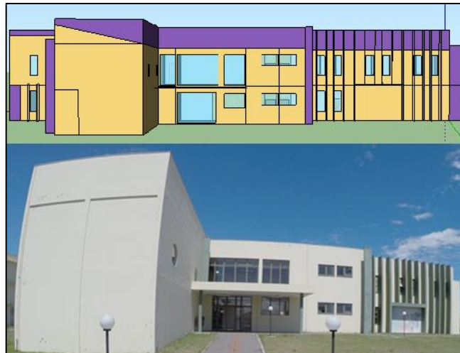
Figura 14 – Fachada oeste do prédio.
