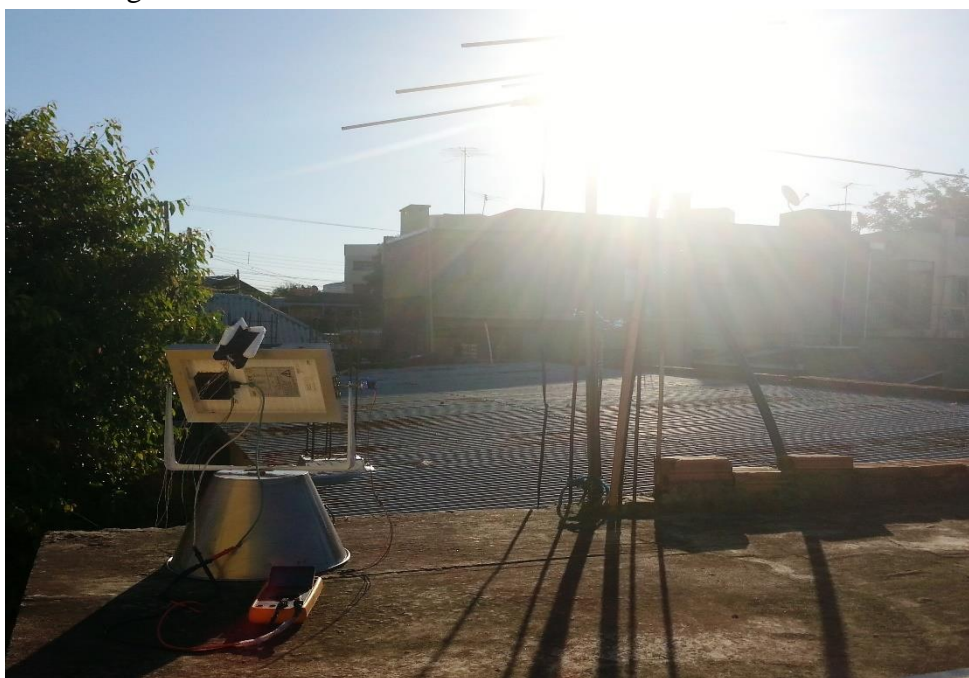
Figura 27 – Sistema fotovoltaico móvel.
