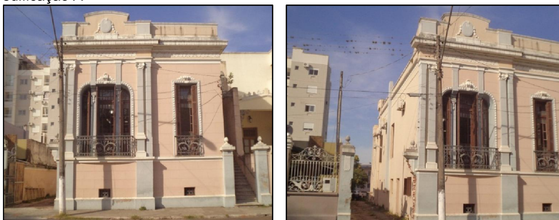
Figura 24 - Fotos da Fachada leste (direita) e da Fachada nordeste (esquerda) da edificação A
