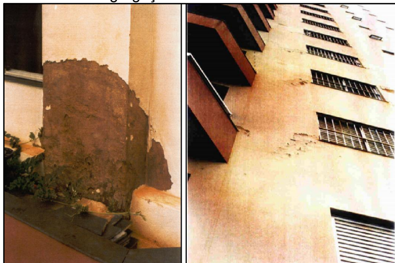
Figura 15 - Detalhes de desagregação
