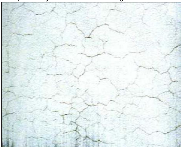
Figura 13 - Fissura por retração no revestimento argamassado
