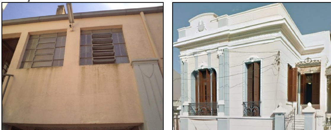
Figura 25 - Fotos da Fachada oeste (direita) e da Fachada sudoeste (esquerda) da edificação A
