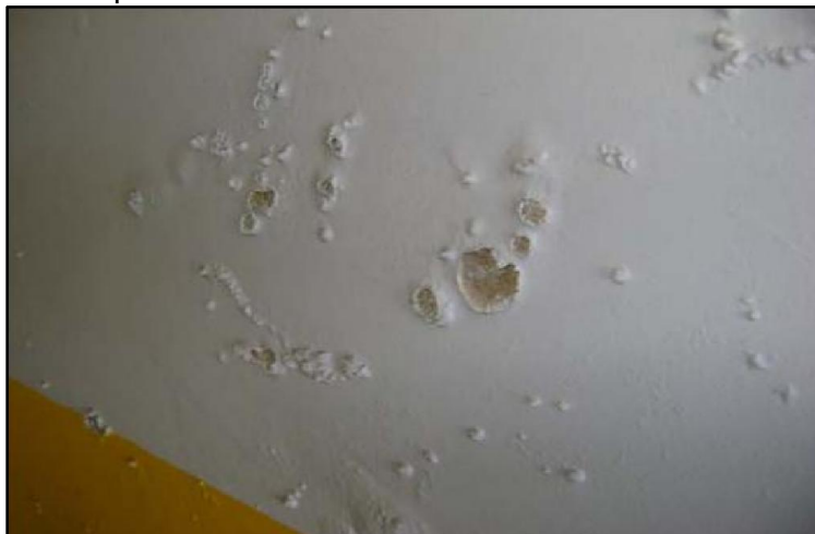
Figura 19 - Vesículas presentes em reboco
