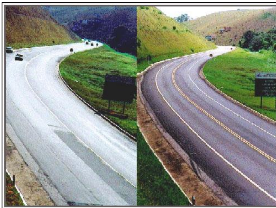
Figura 3 - Pavimento antes e depois da aplicação do microrrevestimento
