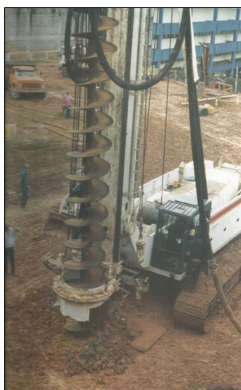
Figura 9 - Estaca hélice contínua sendo executada em obra
