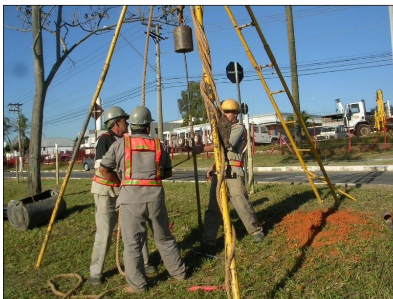
Figura 12 - Execução do ensaio SPT
