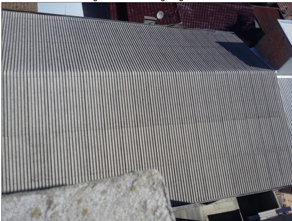
Figura 11 – Telhado do segundo nível das garagens
