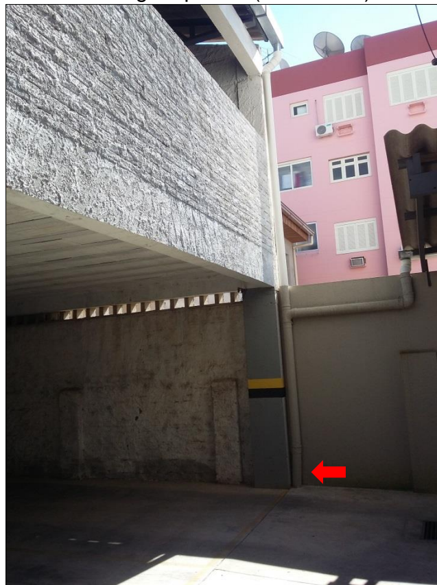
Figura 13 – Conductor de drenagem pluvial (conductor 4)
