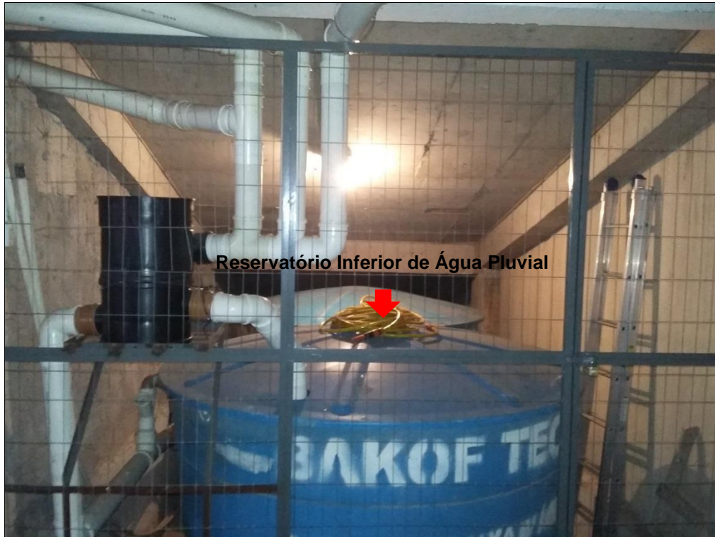
Figura 16 – Reservatório inferior de armazenamento de água pluvial
