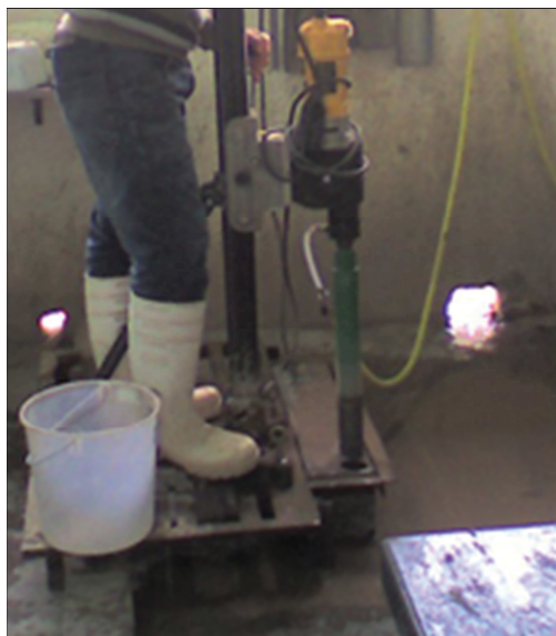
Figura 10 - extração de corpos de prova das vigas por carotagem
