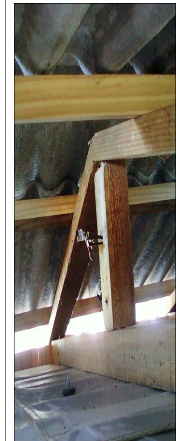
Figura 27: Posição dos sensores abaixo da telha
