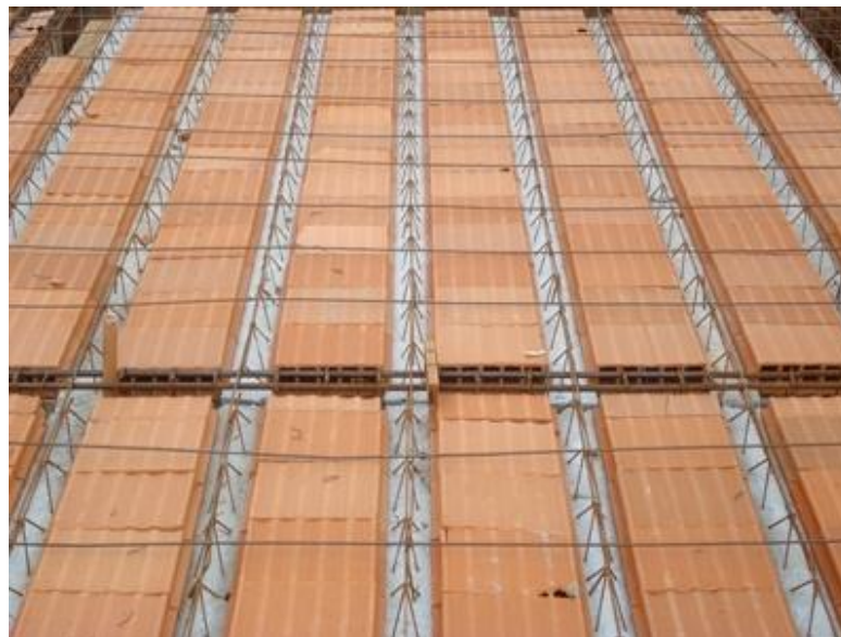
Figura 3—Representação da laje composta por vigotas treliçada
