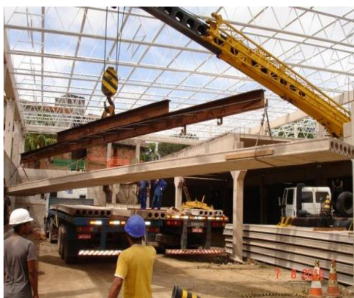
Figura 9 - Içamento de uma Laje Alveolar
