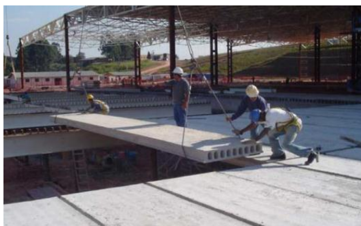
Figura 10- Montagem de uma Laje Alveolar
