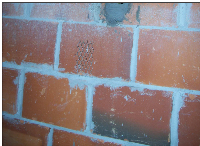
Figura 7 - Argamassa de assentamento em alvenaria não armada
