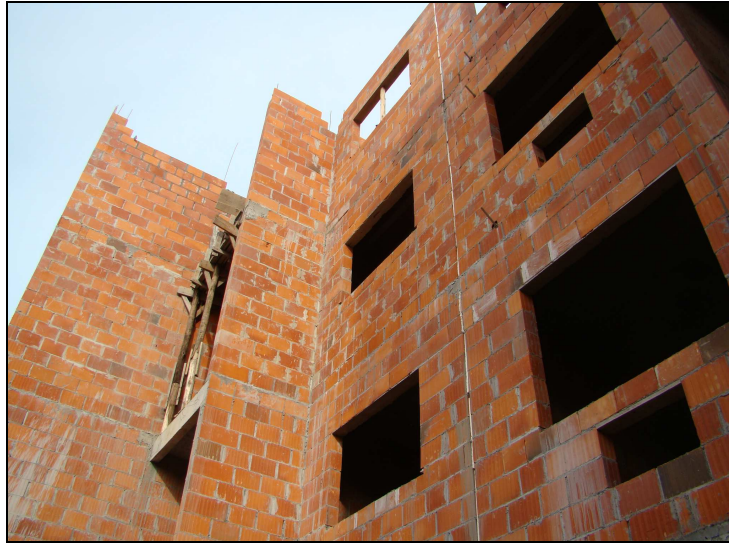
Figura 4 - Modelo de estrutura em alvenaria estrutural
