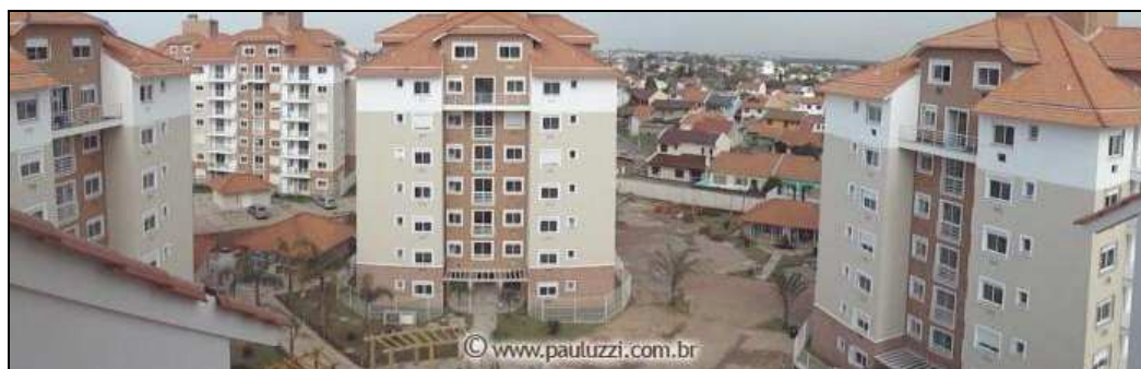
Figura 3 – Empreendimentos construídos em alvenaria estrutural
