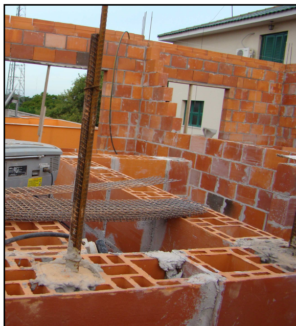
Figura 8 – Armadura utilizada na alvenaria estrutural com preenchimento de grout
