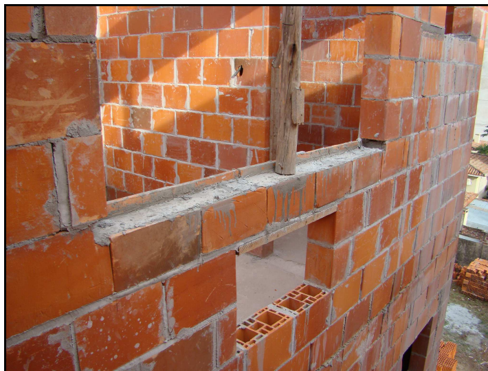
Figura 9 – Detalhe do grout no bloco canaleta
