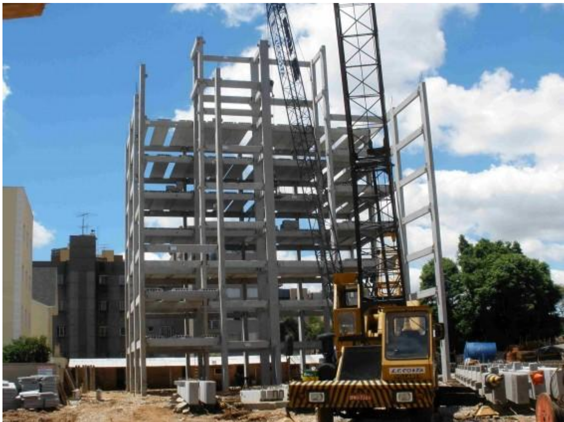
Figura 1.4 - Estrutura de esqueleto de múltiplos pavimentos de grande altura Fonte: http://www.cimentoitambe.com.br
