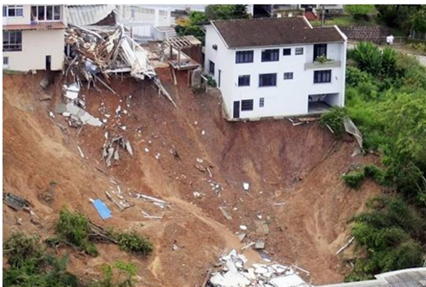
FIGURA 1.1 – Deslizamento de terra em área habitada.
