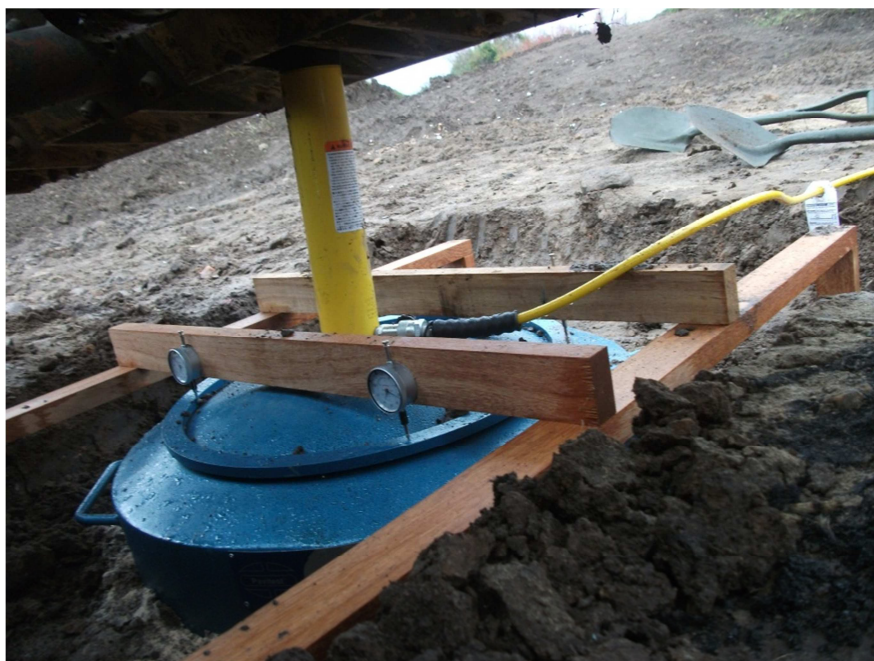
FIGURA 2.6 – Ensaio de Prova de carga em Placa
