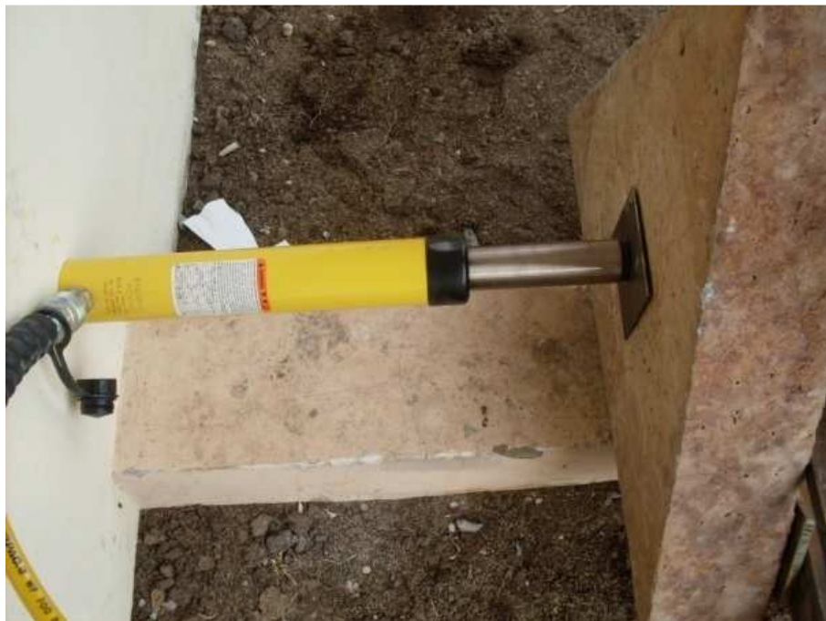
FIGURA 3.11 - Chapa metálica quadrada fixada no centro de aplicação de carga na placa.
