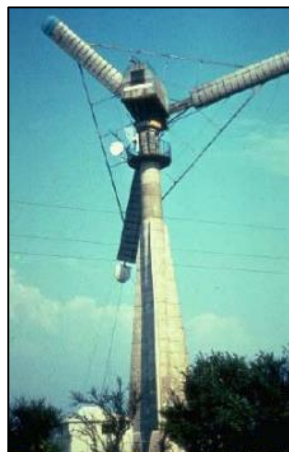
Figura 1.4 – Aerogerador Gedser (200kW, 24m).
