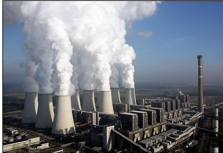
Figura 1 – Usina Termelétrica de Jämschwalde, na Alemanha.
