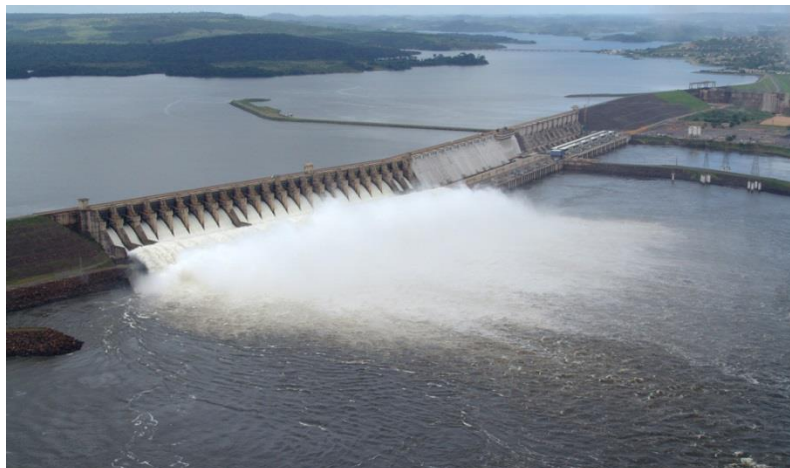
Figura 2 – Usina Hidroelétrica de Tucuruí.
