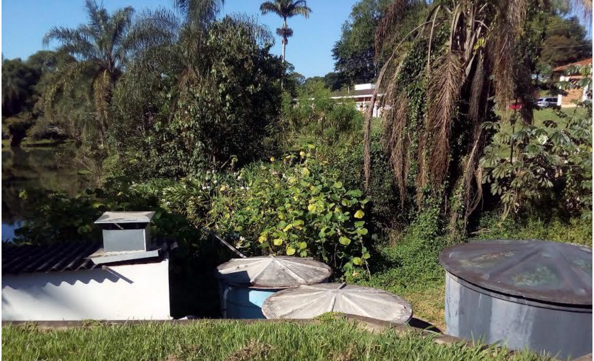
Anexo 1 -Vista superior do sistema de recirculação de água. 3 caixas d'água de fibra de vidro com volume de 4000 L (1ª- utilização do vórtex para a retenção de partículas da saída de água do sistema; 2ª- decantação das partículas ainda existentes com a utilização do cachimbo e 3ª- argila expandida para a formação de colônias de bactérias nitrificantes e oxidação da amônia a nitrato).
