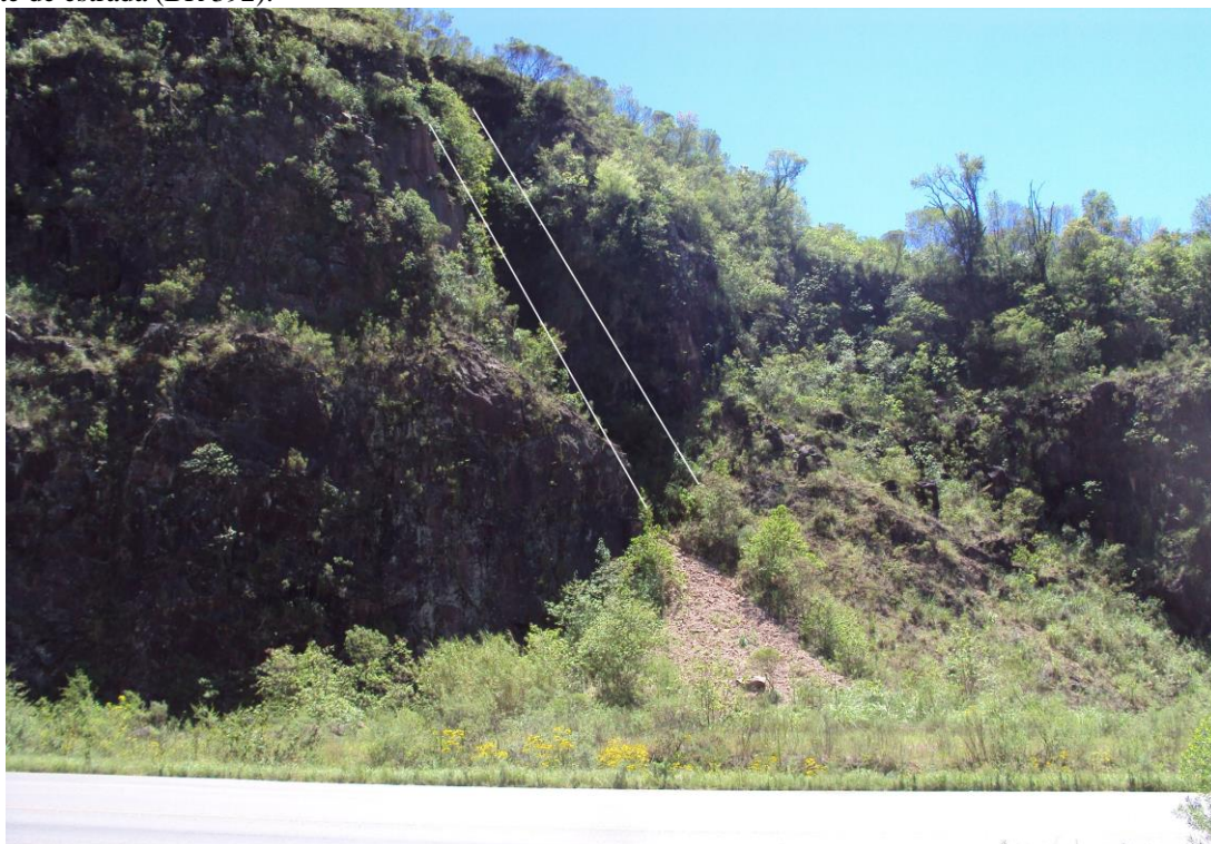
Figura 22 - Dique de diabásio, com alto grau de intemperismo, de direção NW-SE, no ponto 4. Afloramento corte de estrada (BR 392).
