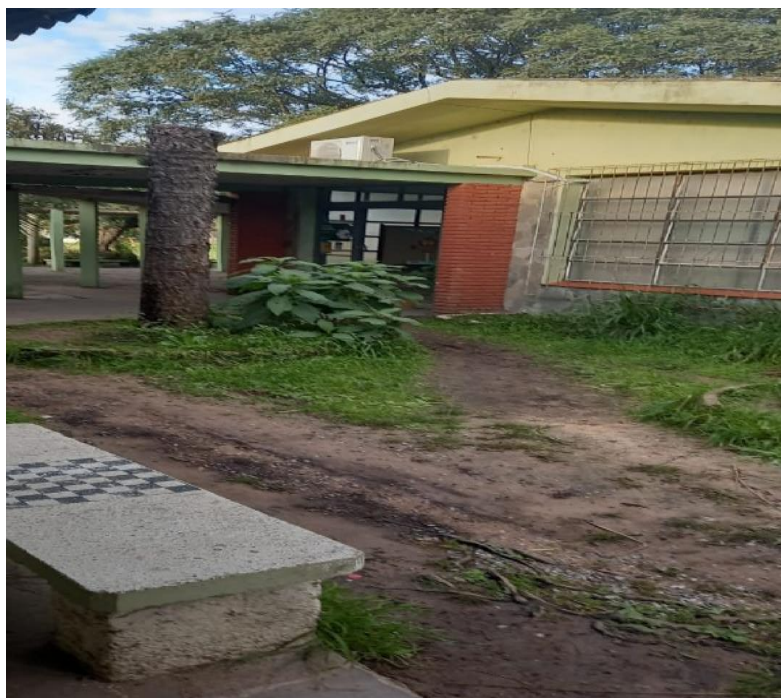
Figura 04 – Entrada e pátio frente da escola
