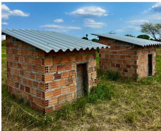
Figura 12 - Protótipos em alvenaria
