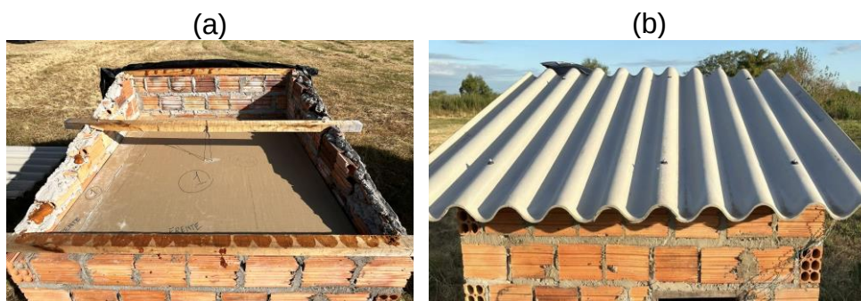
Figura 32 – Sequência de instalação no protótipo referência, onde: (a) Forro de gesso; (b) Telha de fibrocimento.
