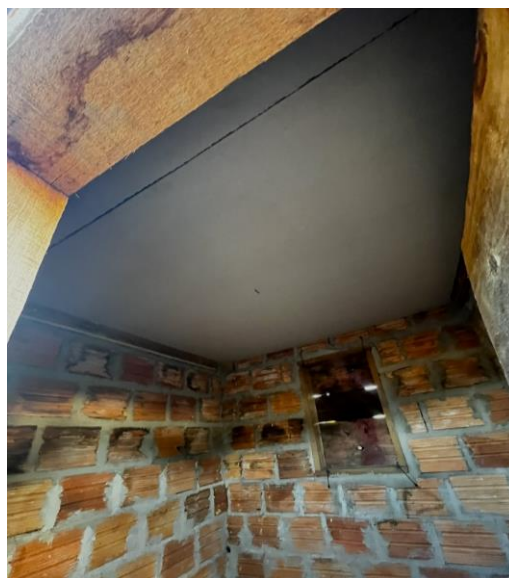
Figura 34 - Vista interna do forro de gesso
