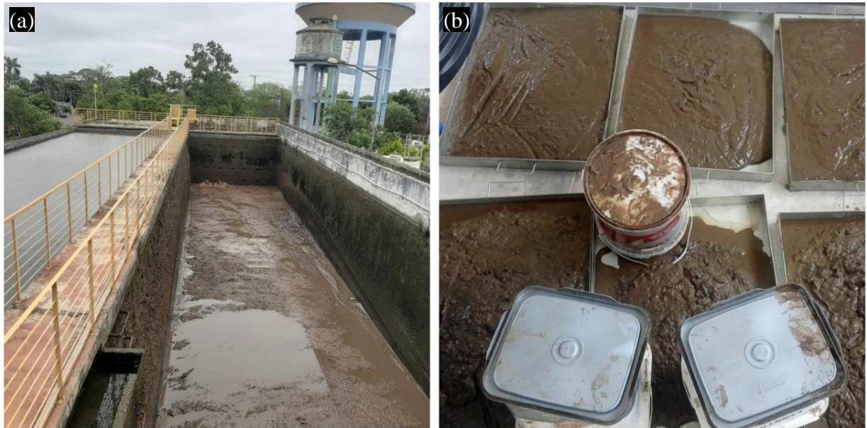
Figura 11 – (a) Limpeza do Decantador; (b) Armazenamento e secagem do lodo ETA.
