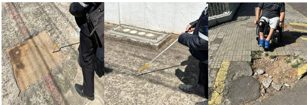
Figura 1- Registro fotográfico sobre condições de rampas e calçadas
